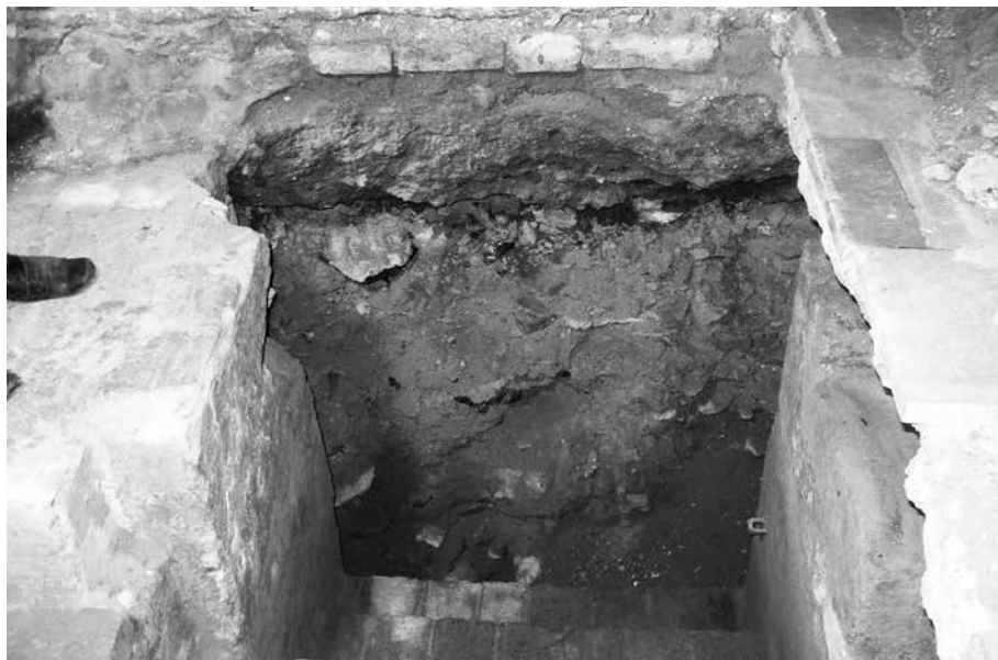
Fot. 3. Kozuchów, kościół farny, dawna kaplica mansjonarzy, widok na wciąż zagruzowane podziemia kaplicy. Fot. J. Lewczuk
