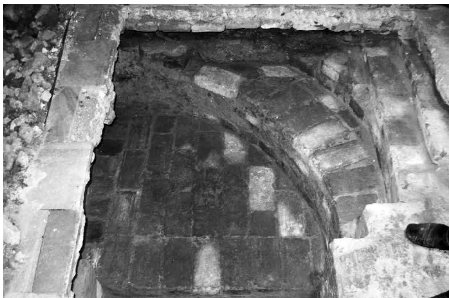
Fot. 2. Kozuchów, kościół farny, dawna kaplica mansjonarzy, odsłonięte w trakcie prac w 2015 r. schody prowadzące do podziemi kaplicy. Fot. J. Lewczuk
