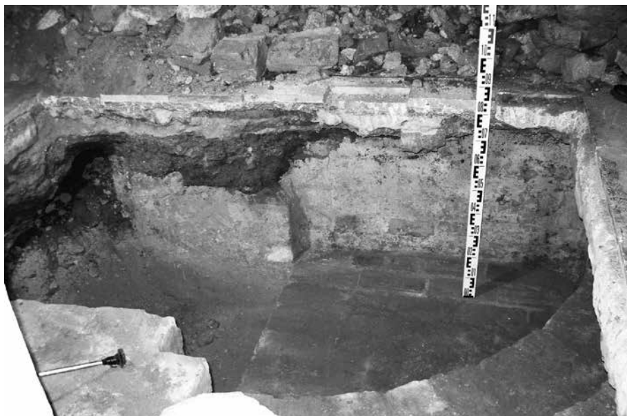
Fot. 4. Kozuchów, kościół farny, dawna kaplica mansjonarzy, ściana północna klatki schodowej na wysokości spocznika, element wtórny zamykający wejście do innych partii podziemi. Fot. J. Lewczuk
