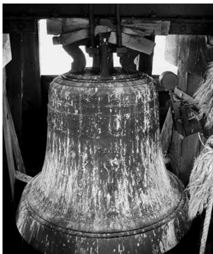
Jerzyce (powiat świebodziński) – źle założona podkładka akustyczna oraz niepoprawne mocowanie bijaka na wysokości szyi i elementów inskrupcyjno-dekoracyjnych
