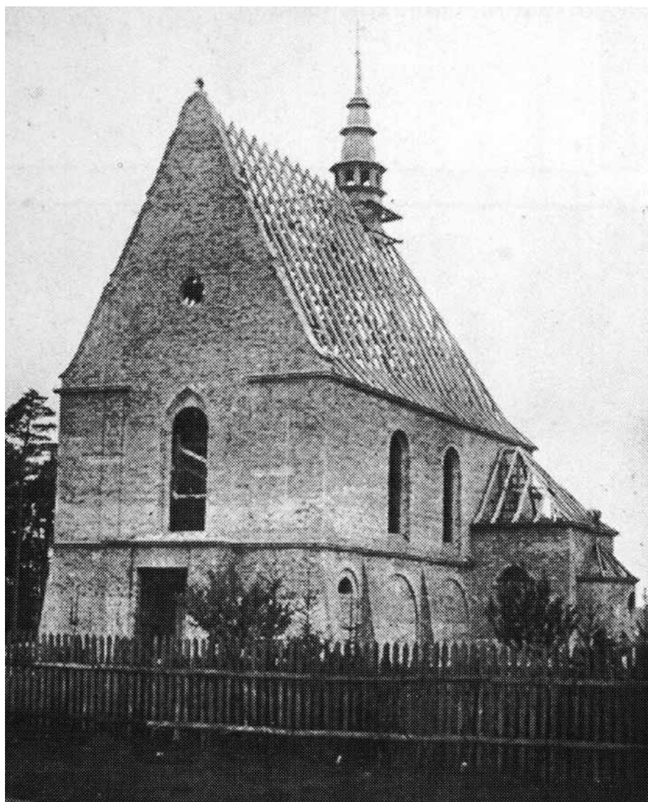
Ryc. 7. Budowa kościoła około 1931 r.
